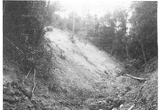
写真3 古野川支川における斜面崩壊
