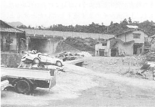
写真7 屋代3丁目ボックスカルバート下流の状況
