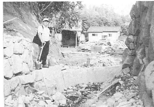
写真5 古野川河道狭窄部
