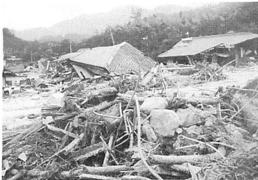
写真1 上小深川地区における家屋の被災状況
