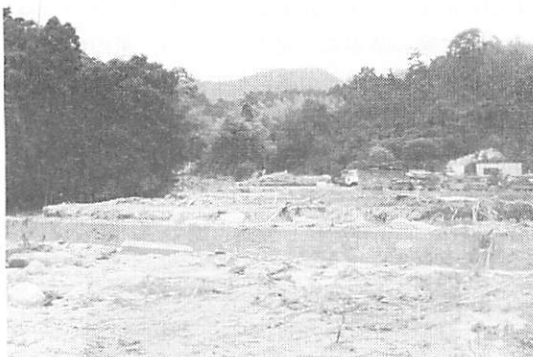
写真8 ボックスカルバート上流の土砂堆積状況
