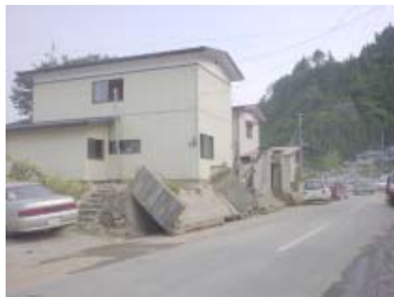
写真2 JR陸中松川駅付近の被害状況
