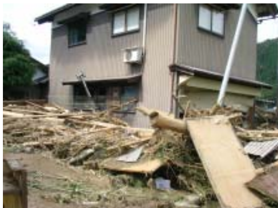
写真 3 洪水流と流木により損壊された家屋。福井市安波賀中島町。図 5 の B 地点。
