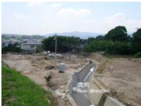
写真 1 太宰府市三条 1 丁目の土石流被災状況
