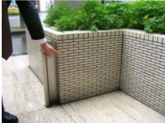
写真9 博多都ホテルの止水板取り付け金具指の位置まで浸水したとのこと。
