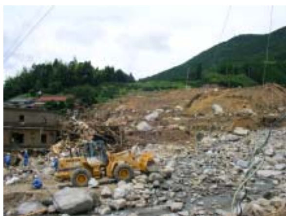
写真 3 集地区の被災状況
