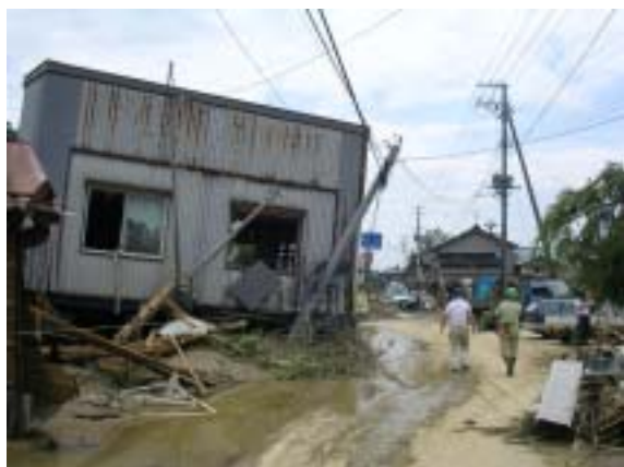
写真 2 中之島町の破堤箇所付近の家屋 複数の住家が建物ごと流されたり破壊されたりしている。図4のA地点。
