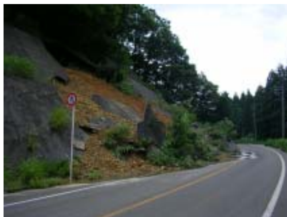
写真 3 栃尾市桑深峠付近の斜面崩壊 図4のB地点。
