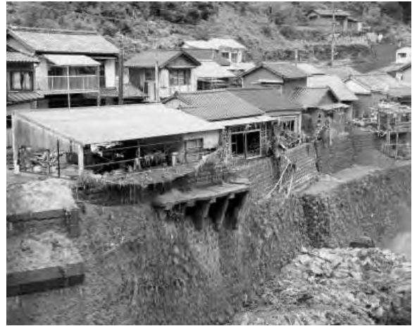
写真 3 洪水流により損壊した宮崎県日之影町神影地区の民家
