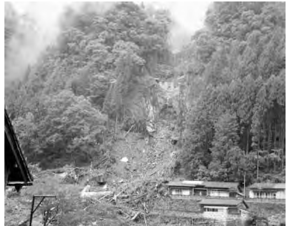
写真 4 宮崎県日之影町神影地区の土石流 .
