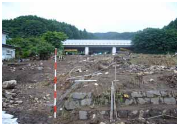
写真 1 長野県岡谷市川岸東二丁目の土石流．中央付近に人的被害を生じた家屋があった．7月21日牛山撮影．
