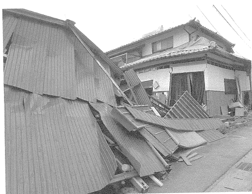
写真8 母屋は倒壊しなかったが納屋の倒壊により犠牲者が生じたと推定される場所
