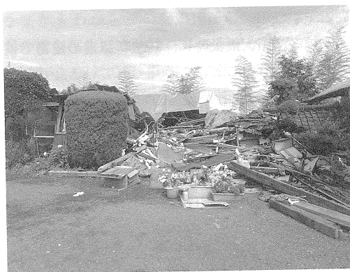
写真9 1階建て建物で犠牲者が発生したと推定される場所(上：西原村鳥子，下：益城町平田)
