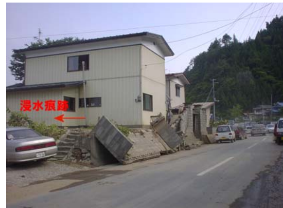
写真 5.2 JR 陸中松川駅付近の浸水家屋 筆者が7月13日に撮影. 1mほど地盤をかかさ上げしているが床上まで浸水. ブロック塀が流水によって破壊された模様.
